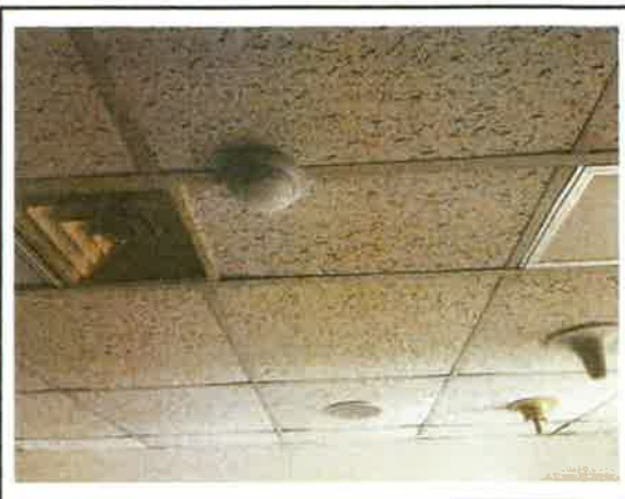
보수내용 감지기 증설 - 후 보수장소 관리동 2F 직원휴게실
