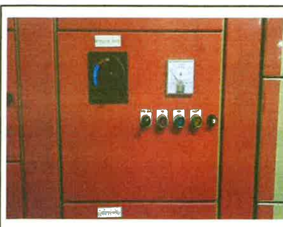
보수내용 OFF스위치 교체 -전 보수장소 공연동 B1F 기계실 MCC판넬
