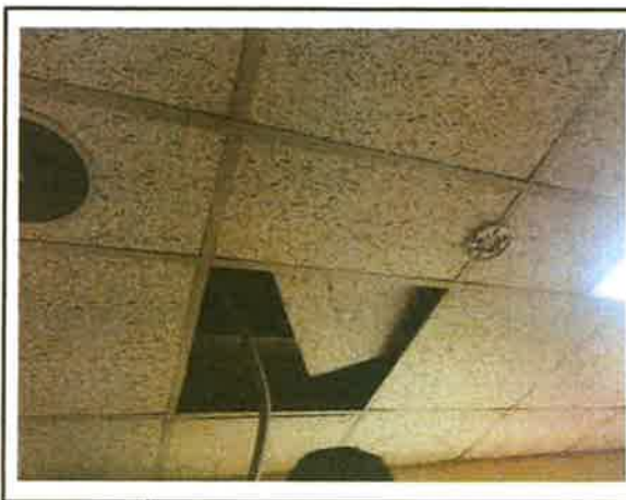
보수내용 감지기 증설 - 전 보수장소 소극장 1층 피아노실 안쪽 실
