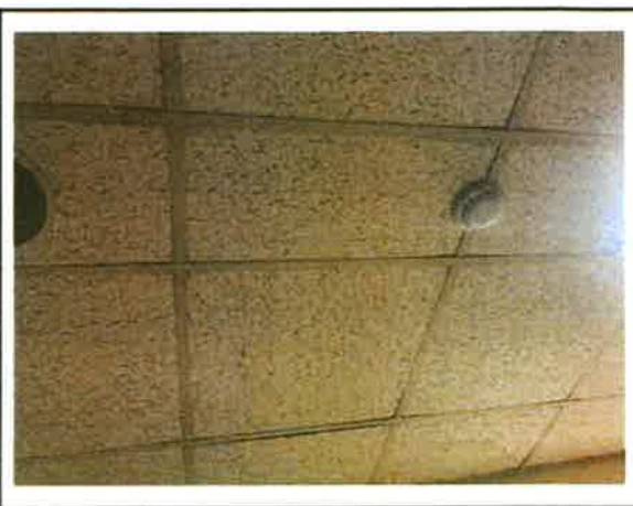
보수내용 감지기 증설 - 후 보수장소 소극장 1층 피아노실 안쪽 실
