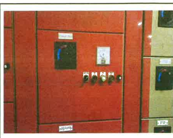
보수내용 OFF스위치 교체 -후 보수장소 공연동 B1F 기계실 MCC판넬
